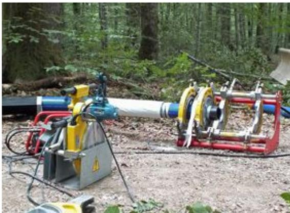
L'opération se révèle complexe car il s'agit de raccorder l'âme du tuyau en soudant parfaitement le polyéthylène à l'aide d'une
