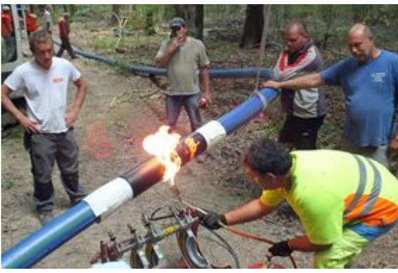
On assure donc le contact avant de terminer par des protections, ruban adhésif et gaines thermorétractables.
